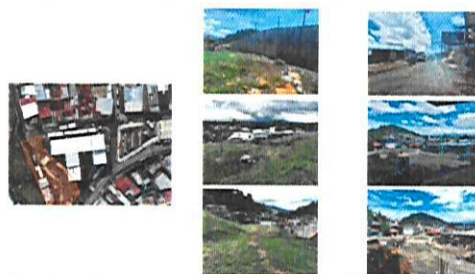
Sector Norte: antes y después
