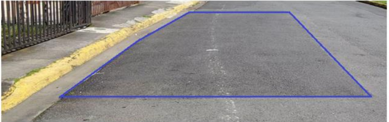
Imagen 3. Obras por bacheo.
