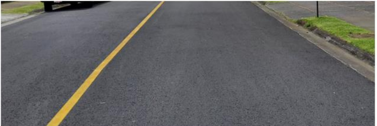
Imagen 4. Obras de recarpeteo.
