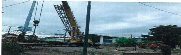
Foto de la instalación de la torre permanente para el punto CT0161, permiso 24-F-2020.
