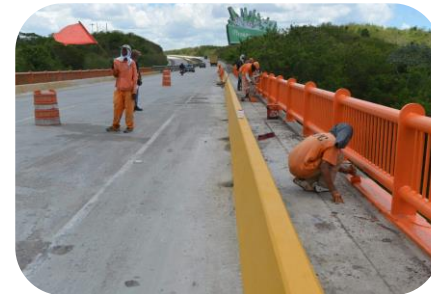
Instalación de barandas y barreras en el puente
