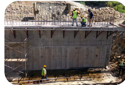
Colocación de concreto estructural y acero de refuerzo en bastiones
