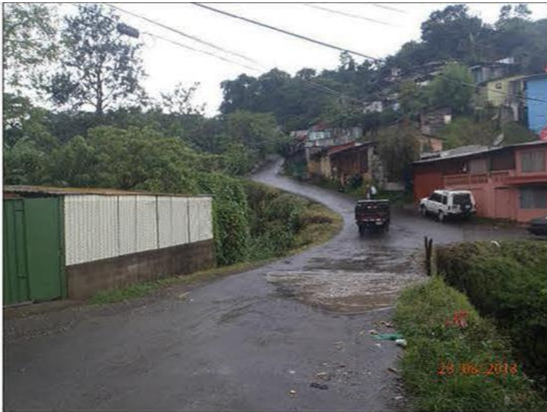
Antes de la intervención
