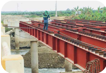
Colocación de vigas metálicas
