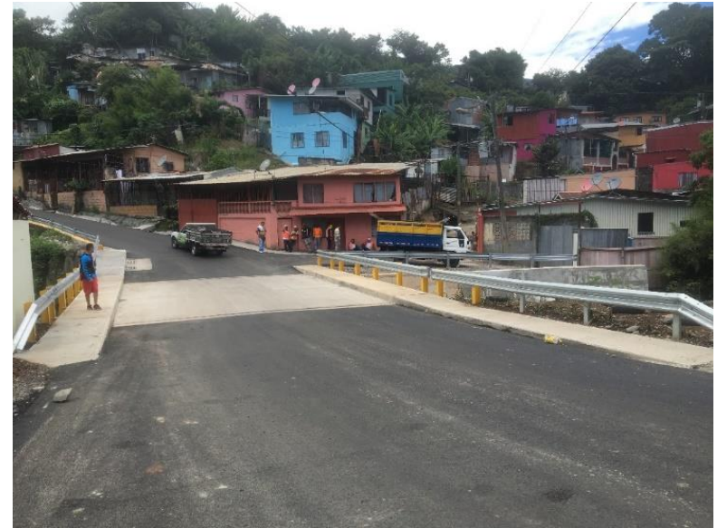
Alcantarilla después de la intervención
