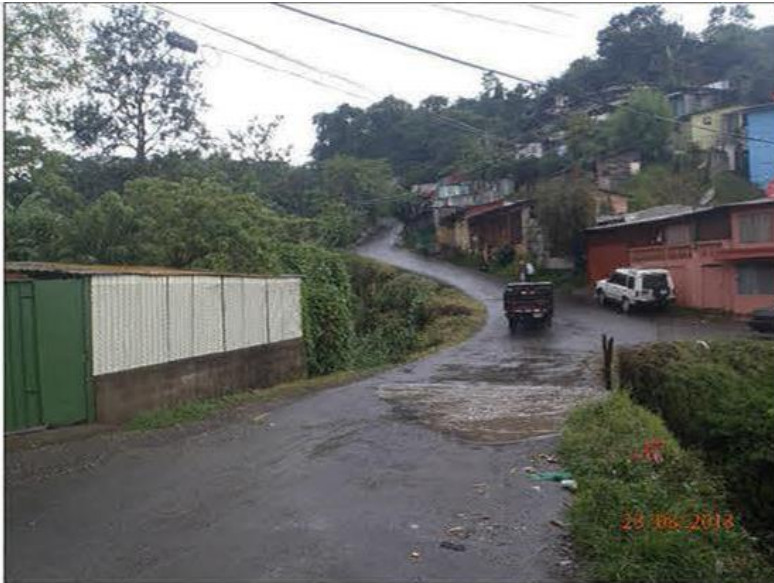
Alcantarilla antes de la intervención
