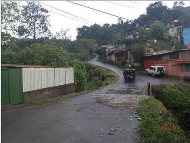
Alcantarilla antes de la intervención
